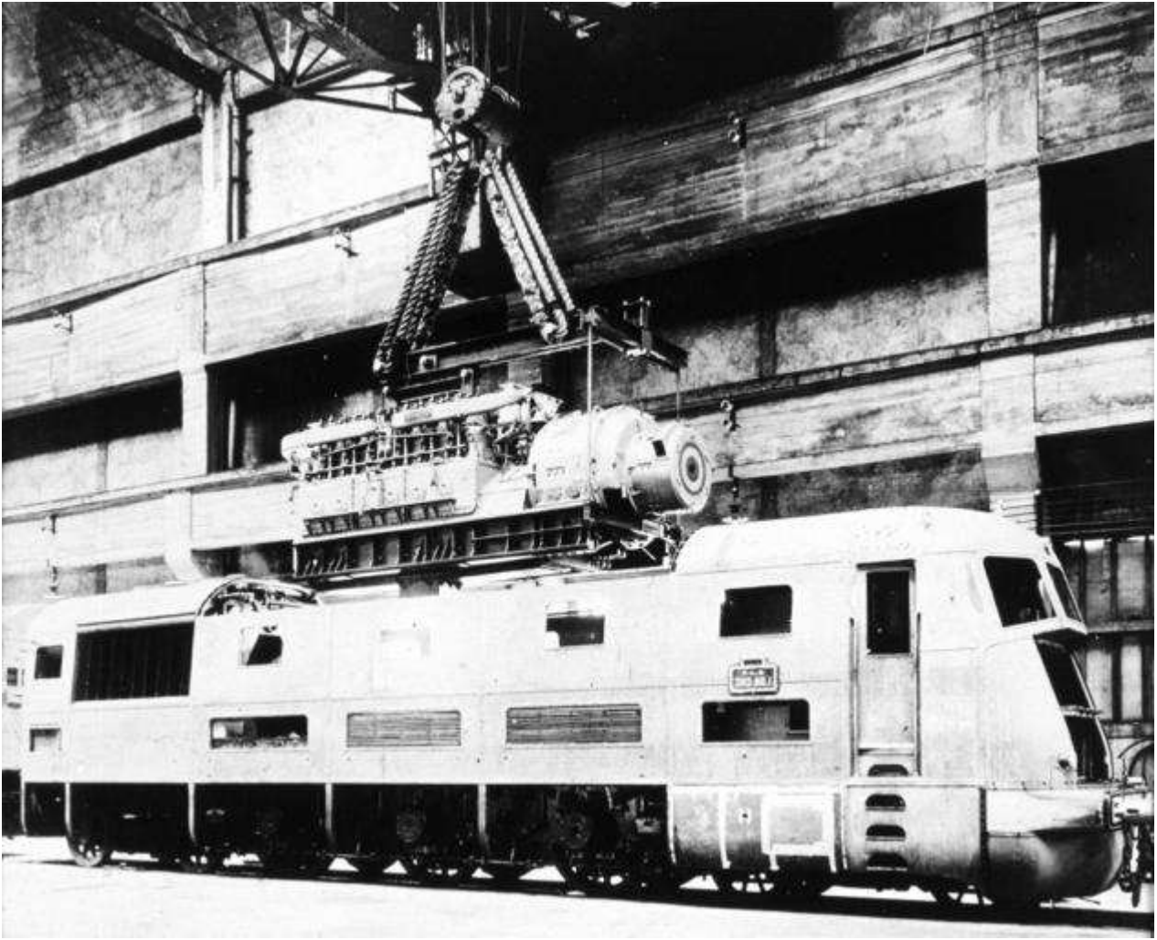
Montage d'une moteur SULZER dans la 262 BD1 (Atelier PLM)
